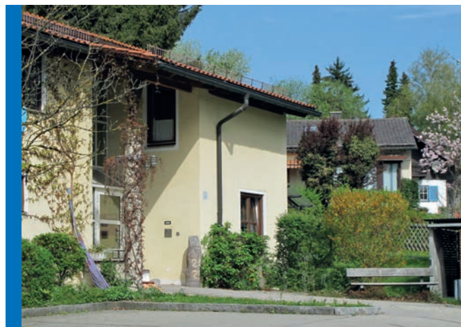
Das Wohnheim an der Hanfelder Straße soll 2023 erweitert werden.
